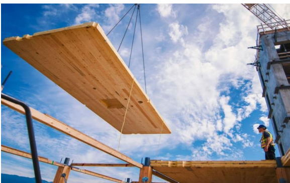
Рис. 4. Монтаж CLT- плиты перекрытия
