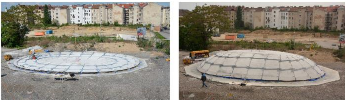
Рис. 3. Возведение прототипа оболочки вращения
