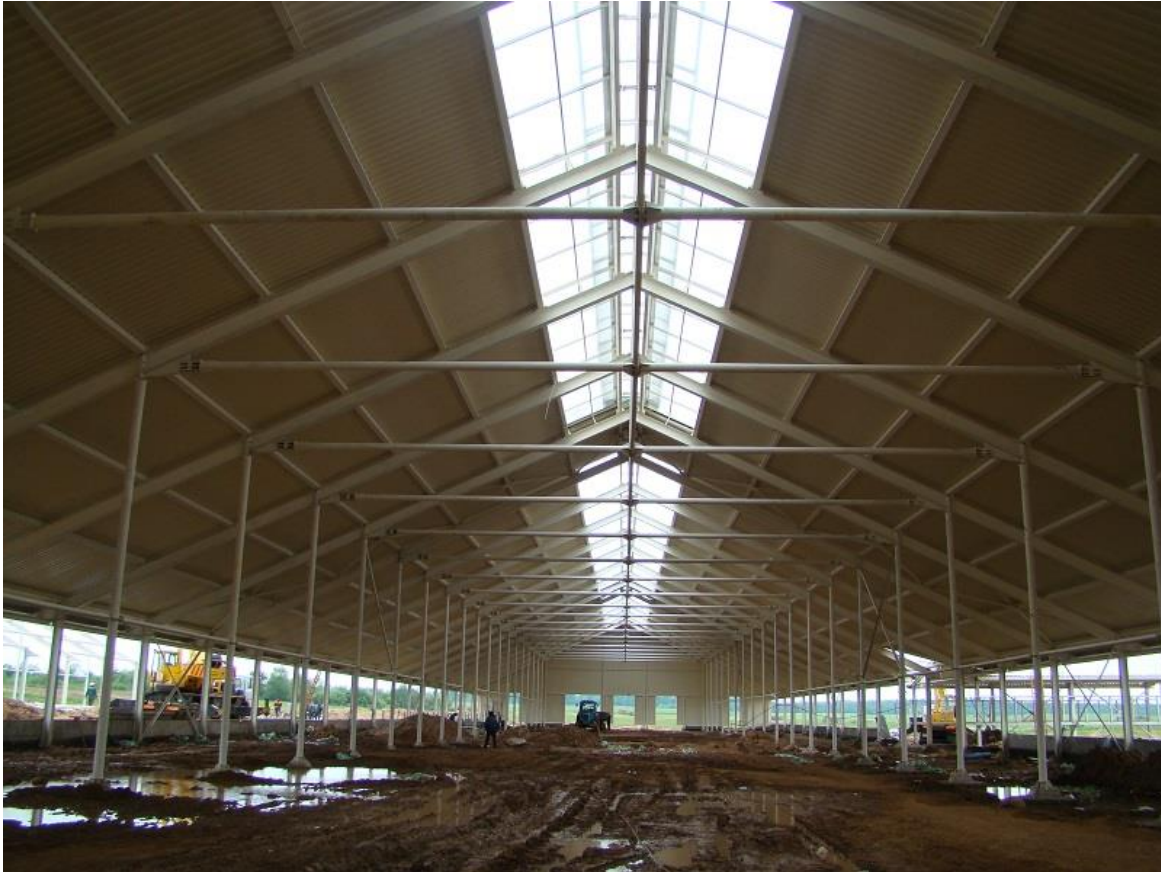
Рис. 1. Каркас фермы КРС из металлоконструкций
