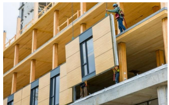
Рис. 5. Монтаж фасадной стеновой
