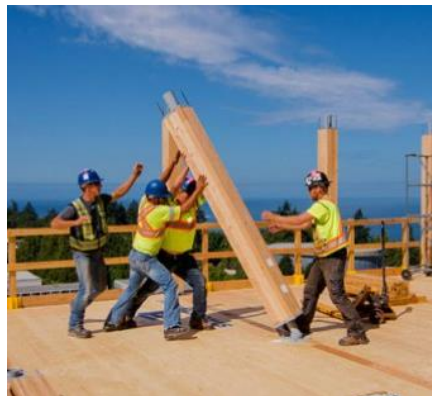
Рис. 3. Установка колонны
